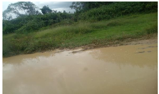
La voie menant d'Akoupé-Zeudji o la zone Industrielle
