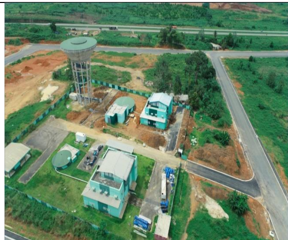
Image présentant un chateau d'eau et un poste de neutralisation et de désinfection de PK 24 Akoupé-Zeudji
